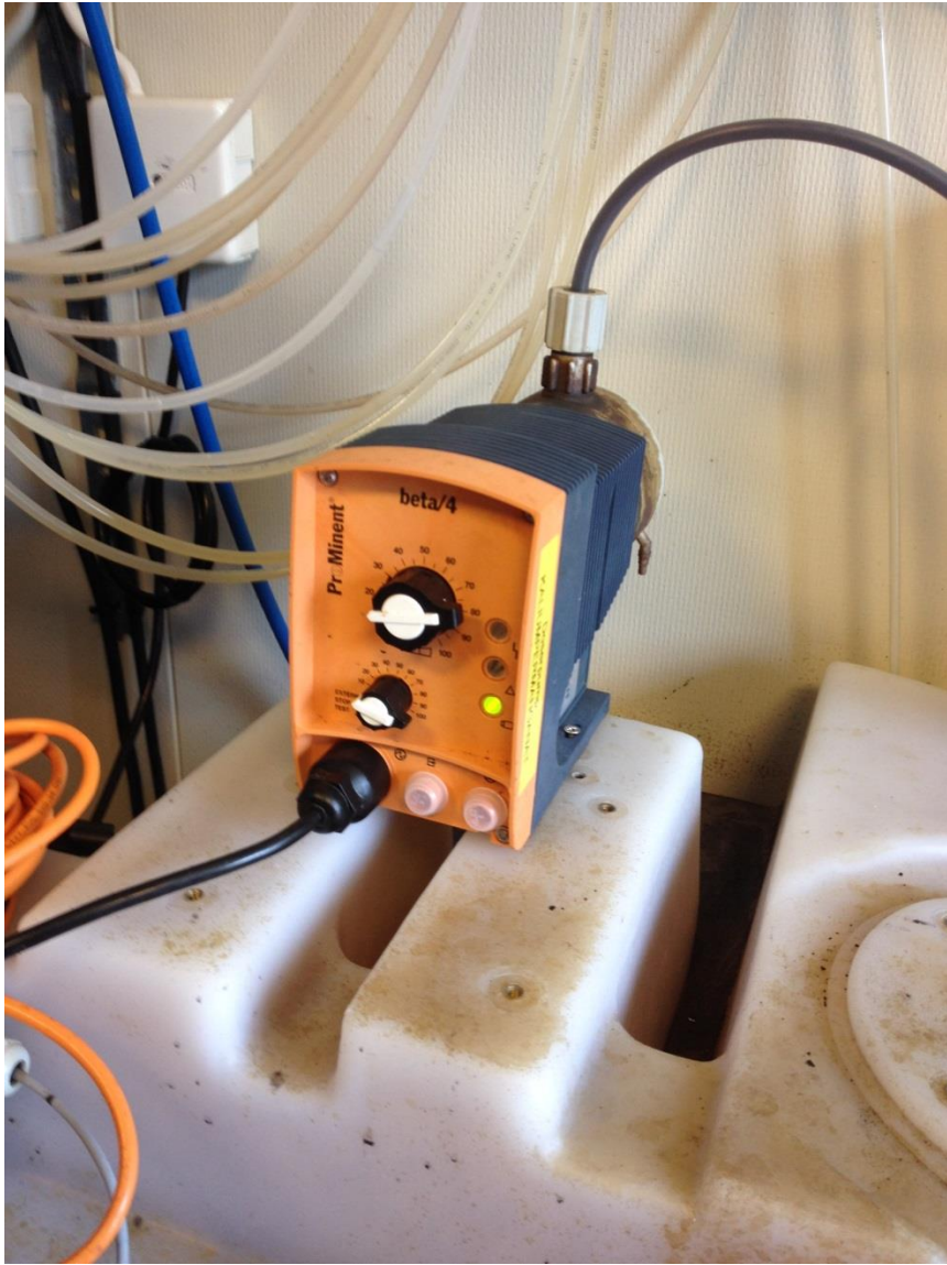
Dosering av kaliumpermanganat
