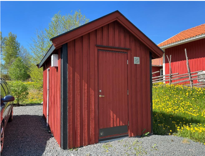
Figur 3. Skinnersdals vattenverk med placering i norra byområdet.
